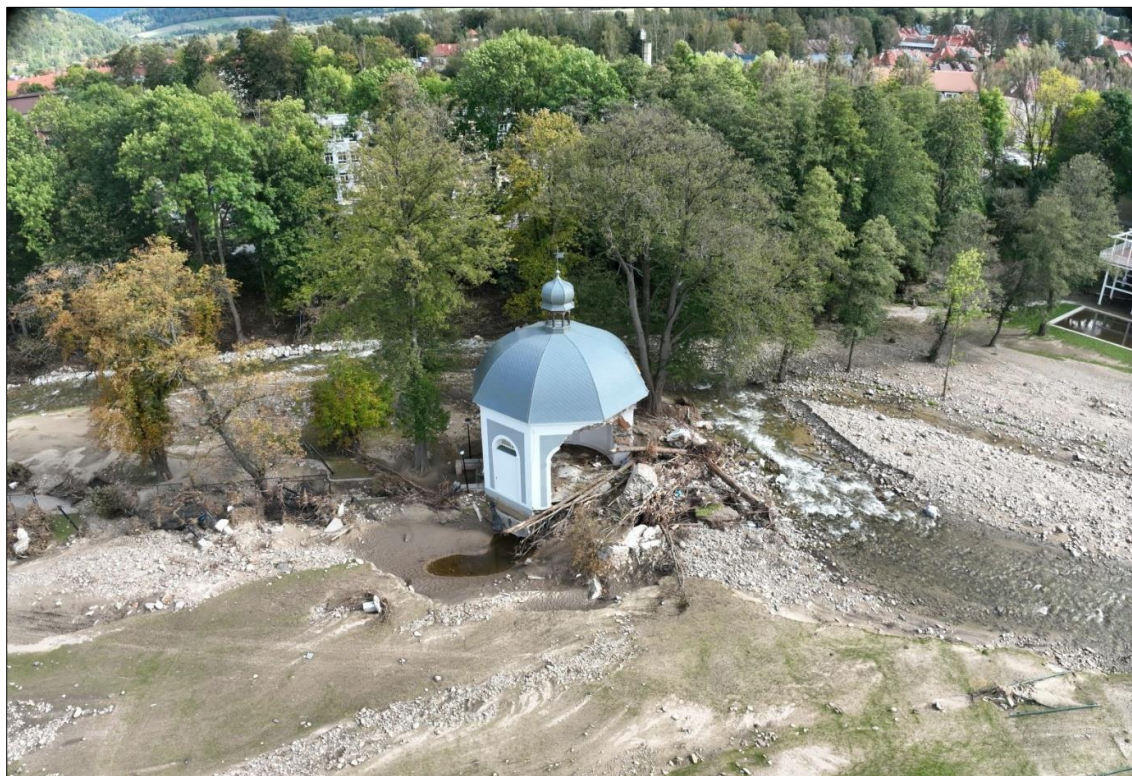
Kaplica św. Onufrego w Stroniu Śląskim zniszczona przez falę powodziową.
